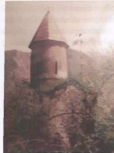
Kiş məbəəd-kilsəsi bərpadan əvvəl
